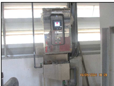
ภาพที่ 3.38 เครื่องตรวจวัดน้ำอัตโนมัติแบบต่อเนื่อง และหน้าจอแสดงผล
