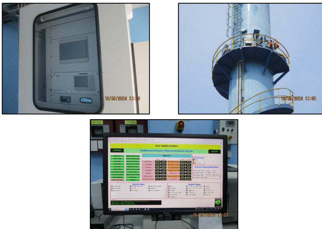
ภาพที่ 3.27 เครื่องตรวจวัดคุณภาพอากาศจากปล่องแบบต่อเนื่อง (CEMs)
